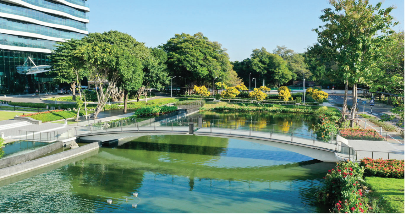
CPAC Ultra Bridge Solution นวัตกรรมสะพานคอนกรีตผสมปูนสูงที่บางที่สุดแห่งแรก ในประเทศไทยและอาเซียน ด้วยเทคโนโลยี UHPC (Ultra high Performance Concrete)
